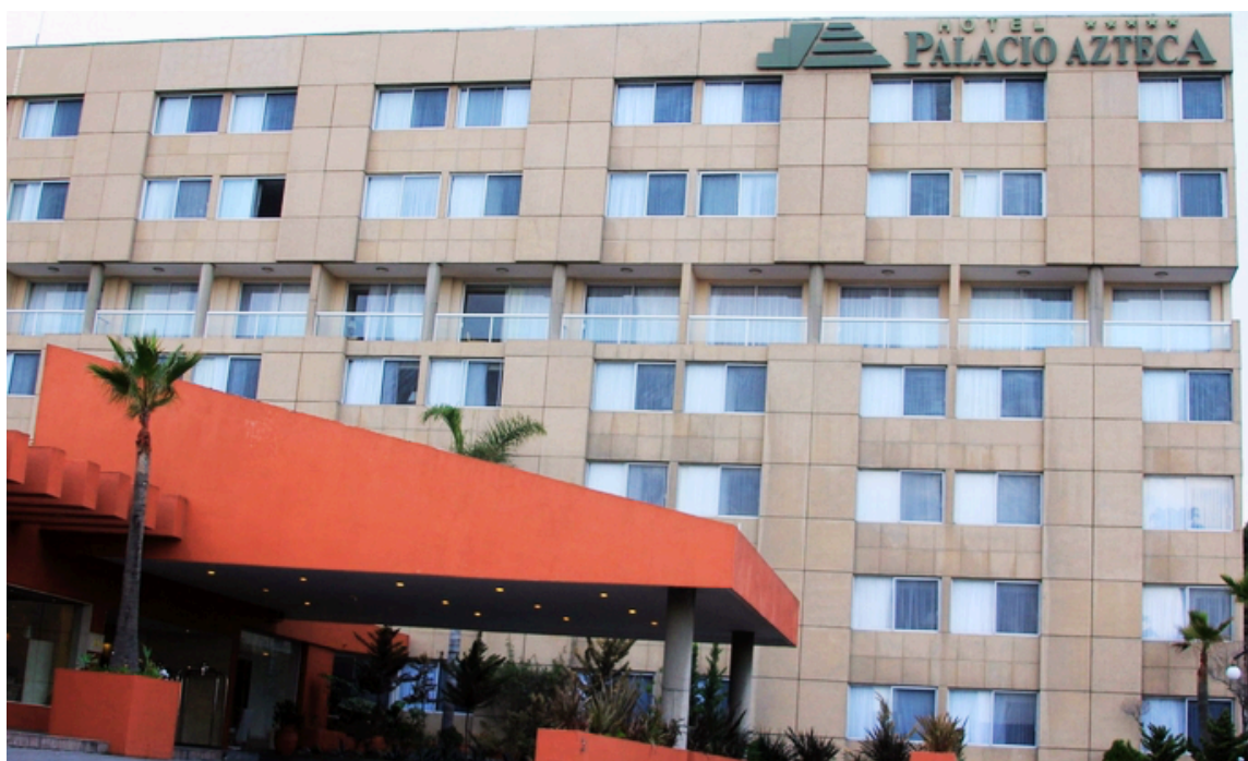
Hotel Palacio Azteca Boulevard Cuauhtémoc Sur 213, Colonia Dávila, 22044, Tijuana, B.C.
